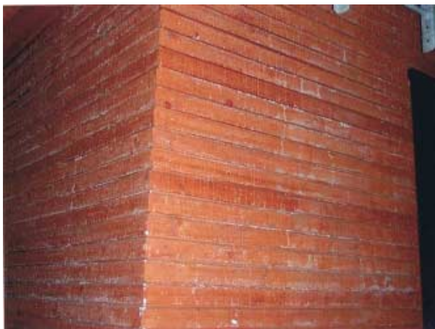
Skador och saltutfällningar på brandskyddad fasadpanel (utan bruksklass) i Norge.
