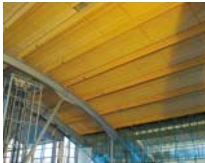
Invändiga paneler är ett lämpligt användningsområde för brandskyddat trä. Exempel från flygplatsen Gardemoen i Norge.
