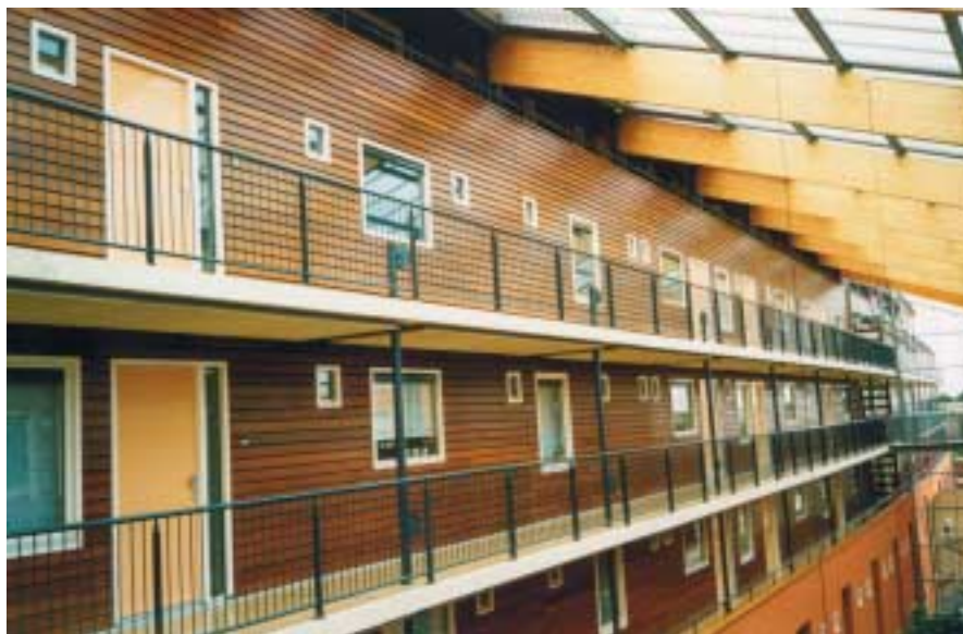
Ett lämpligt användningsområde för brandskyddat trä är invändiga vägg- och takpaneler i brandsäker byggnad Br 1 där hög ytskiktclass krävs. Bruksklass I bör användas.
